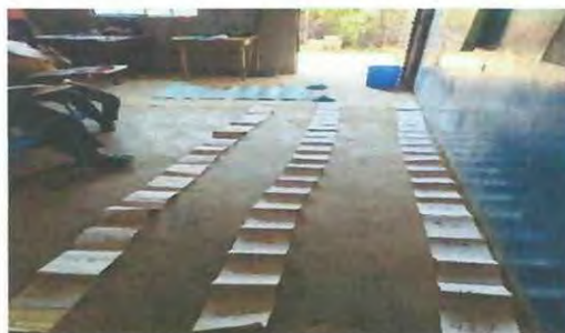
Foto 2: Cambio de piso entortado a piso ceramico
