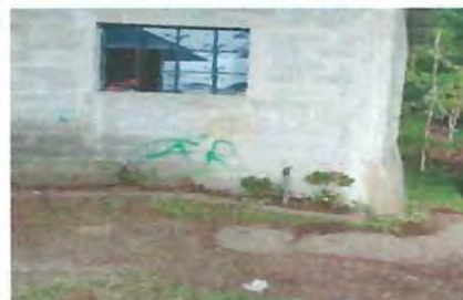
Foto 6: Se necesita hacer cunetas para evitar que el agua se filtre en las paredes y arruinar el cimientto de las aulas.
