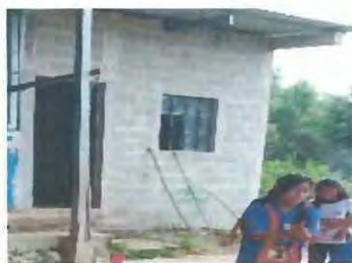
Foto 3: Cambio de puertas de metal
